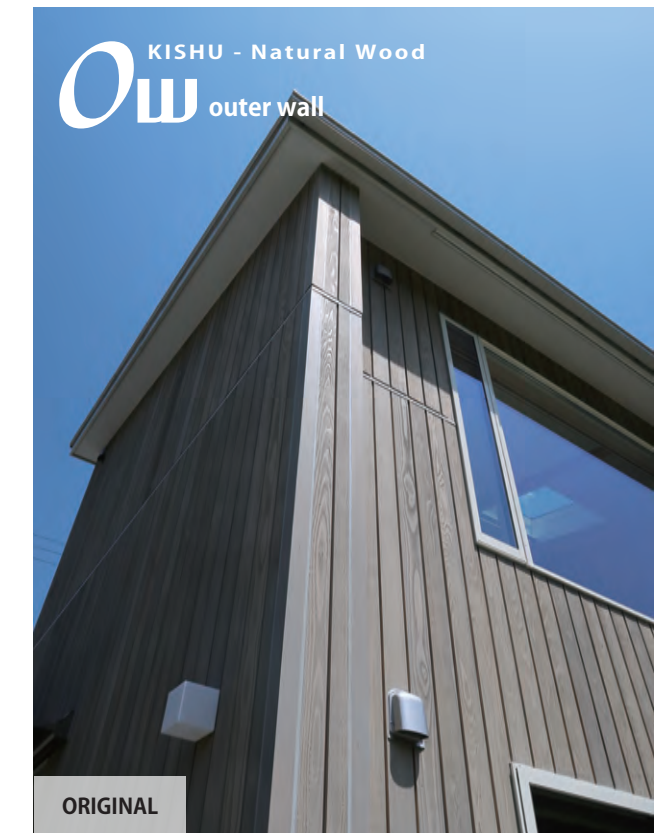
ゲストハウス中辺路 外壁材/Ow 杉板縦貼り
