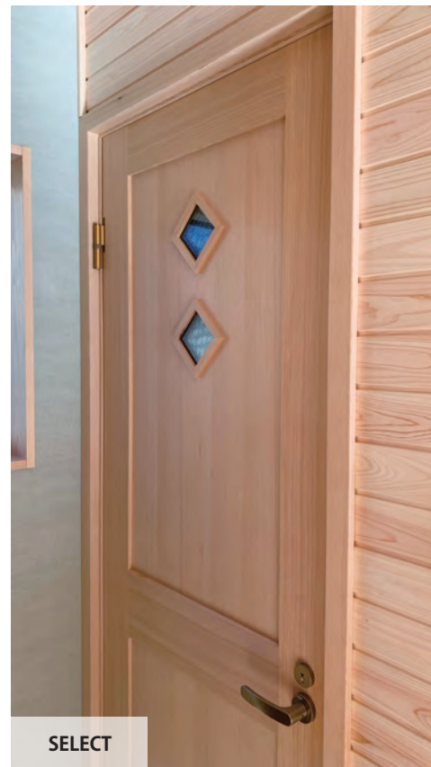
ゲストハウス中辺路 室内ドア/ヘム(水性クリア仕上げ)
