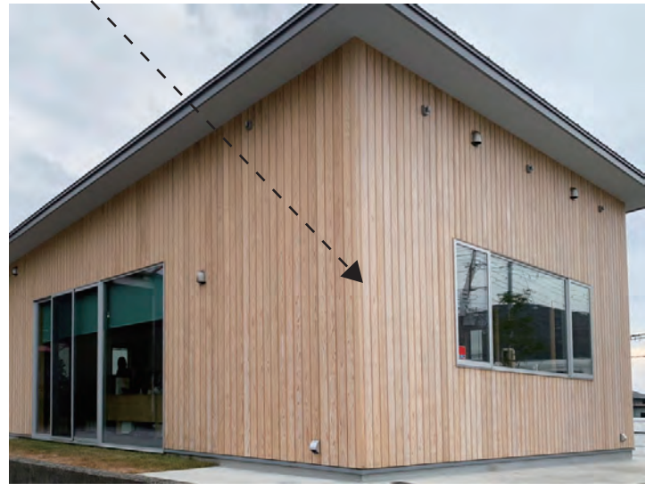
1年後の Ow 国産杉 縦張り エムフェクト：クリア塗装 経年変化で色が馴染んでいきます。（源平の赤白も同様）
