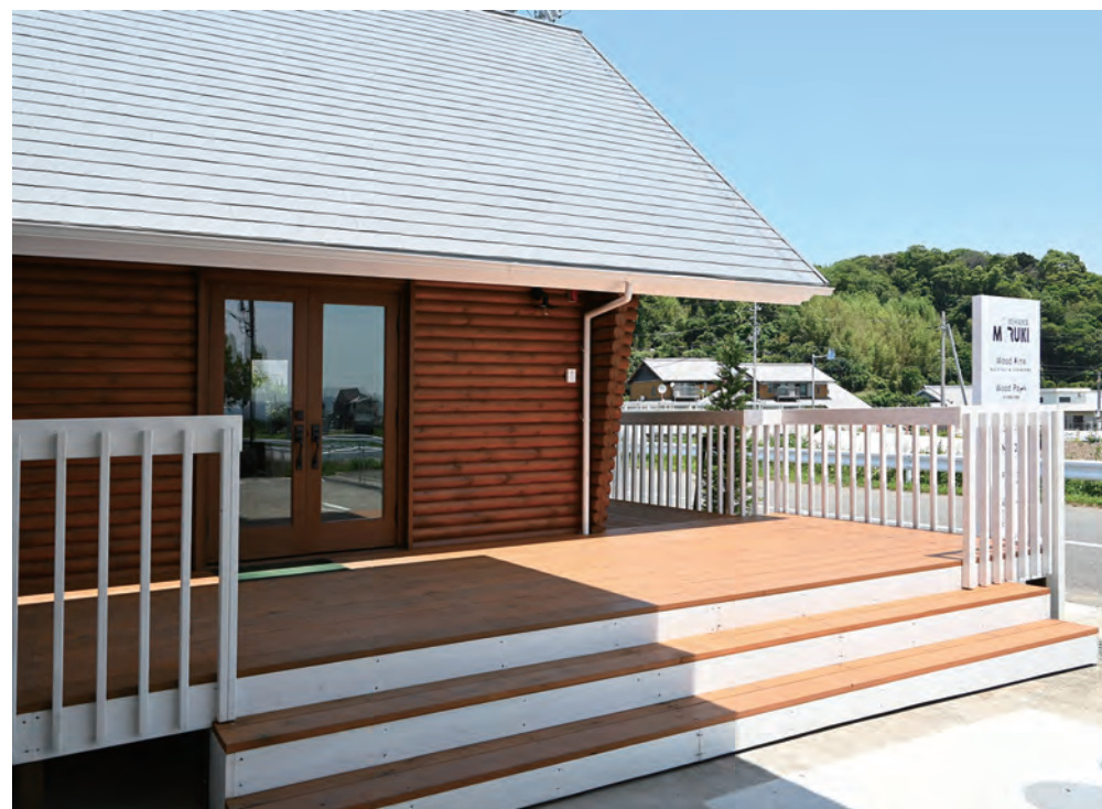
ハーフログパネリング:杉 無垢デッキ/笠木/手摺子:レッドシダー 塗装:すべてM-FECT塗装
